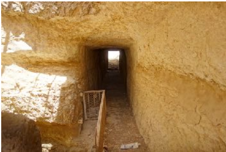
L'analyse de l'intérieur du tunnel lui-même semble confirmer cette fonction de déversoir des eaux de pluie vers le sud. Un puits vertical a été creusé dans la chaussée elle-même, dans le trottoir sud, mais celui-ci semble plus tardif.
